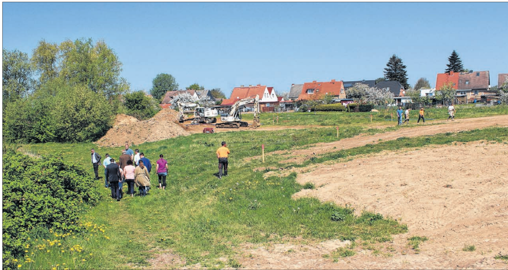
Westlich der Kalkhorster St. Laurentius-Kirche werden Bauplätze für 25 neue Wohnhäuser vorbereitet.
