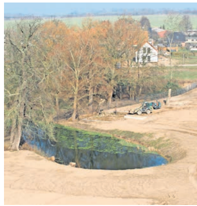
Der Entdeckerpark Minimare wird in der Gemeinde Kalkhorst in Nordwestmecklenburg gebaut. Die Firma Garten- und Landschaftsbau Tulpe aus Lübeck legt das Gelände an. Am 1. Juli wird der Park eröffnet.
